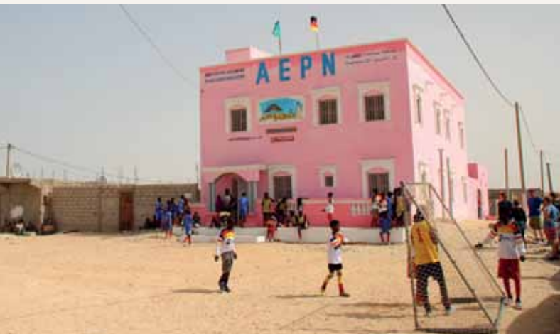
Im Januar 2014 fertiggestelltes Kinderhaus in Nouadhibou
